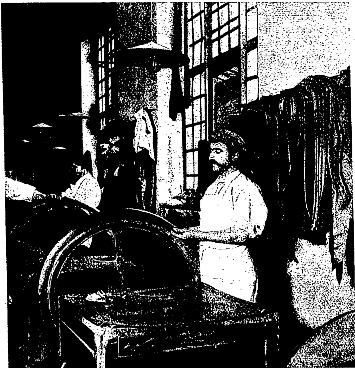
FABRICATION DU BANDAGE
