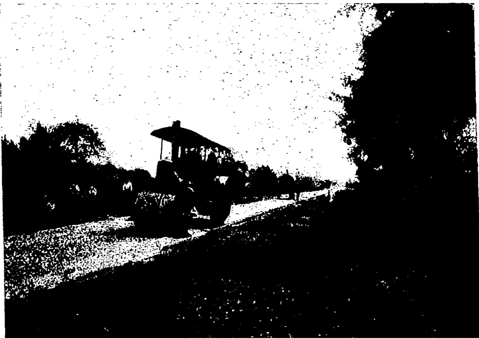
CYLINDRAGE DE LA CHAUSSÉE ET ÉPANDAGE DU GOUDRON
